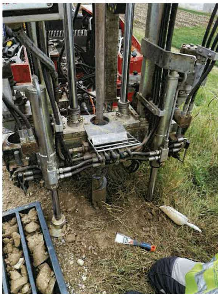
Carotaggio mediante sonda carotatrice con aste elicoidali
